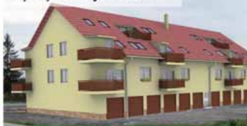
Bytový dům Kyselovská
